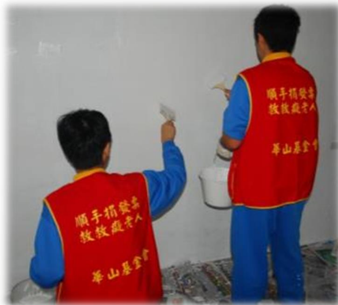
居家改善-房屋修繕
